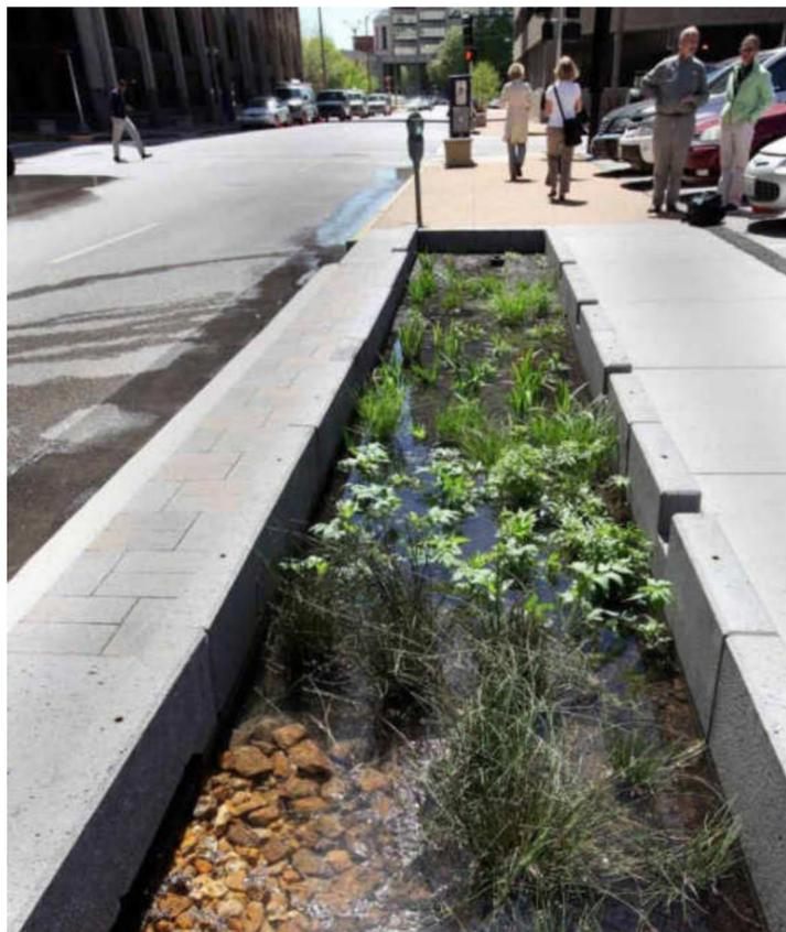
Resilienza idraulica: rallentare la portata d'acqua a valle per contrastare il deflusso lento dell'acqua meteorica nel terreno dovuto alla semi-permeabilità dei suoli dei versanti.
