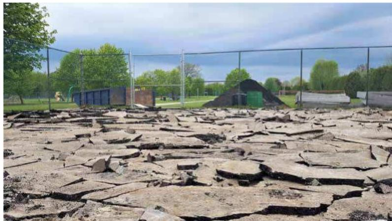
Depaving: restituire una matrice di suolo paranaturale per recuperare aree precedentemente infrastrutturate.
