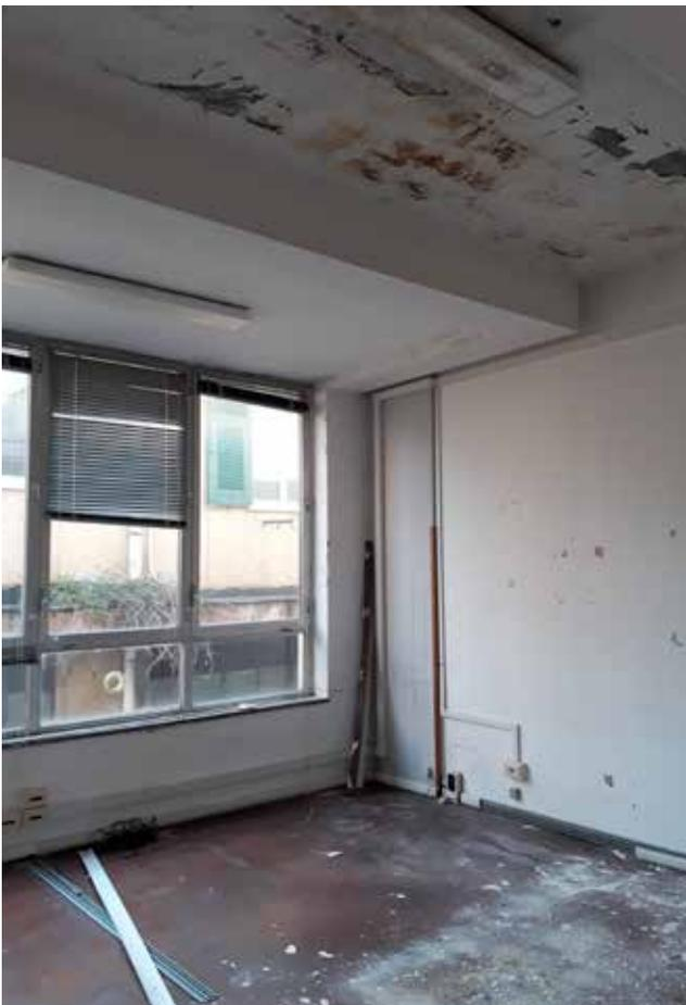
*Dettaglio del degrado causato dalle infiltrazioni nei locali posti a est*
