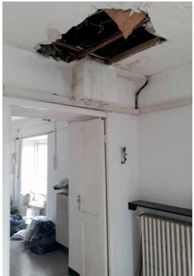
Vista di situazioni puntuali di degrado e distacco di intonaci rilevate al sesto piano dovute alle infiltrazioni dalla terrazza in copertura
