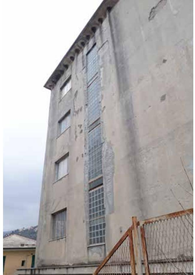
*Viste dei fronti esterni dalle quali si possono notare i distacchi di intonaco e di elementi architettonici (cornicioni)*
