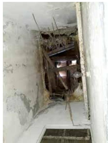
*Dettagli del degrado e del cedimento di alcuni incannucciati di copertura posti al primo piano*
