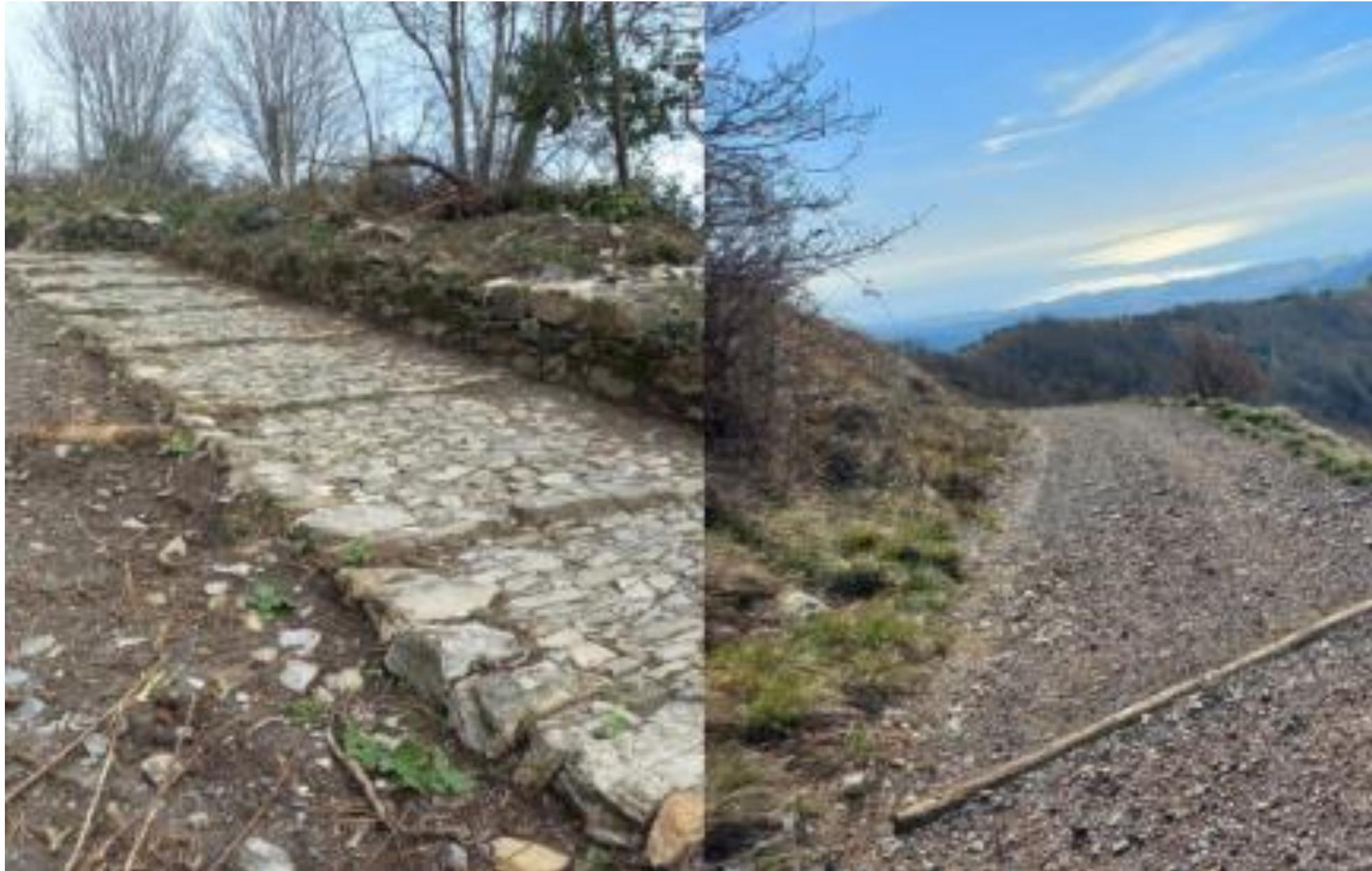
*Regimazione delle acque superficiali attraverso la messa in opera di tronchi rompitratta lungo il percorso di crinale e nel tratto periurbano. Le acque saranno infine allontanate tramite sistemi dissipatori costituiti da sistemi drenanti in pietrame e/o legname (palizzate) paesaggisticamente compatibili con il contesto.*
